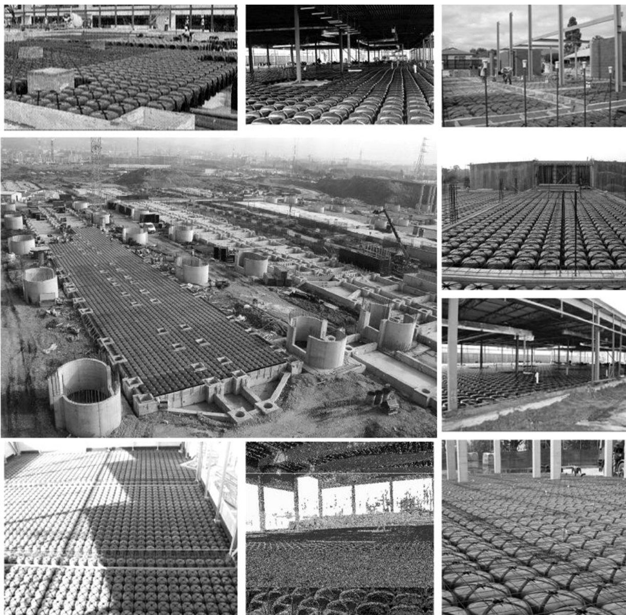
Figura 6 - Exemplos de instalações diversas de pavimentos Cupolex.
