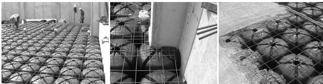
Figura 7 - Fases de montagem do pavimento Cupolex.
