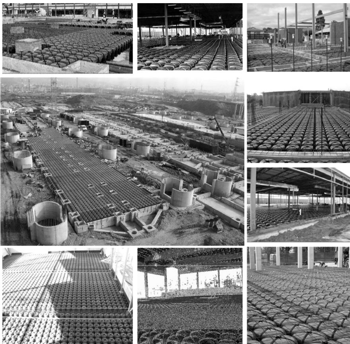
Figure 6 - Exemples d'installations diverses de planchers Cupolex.
