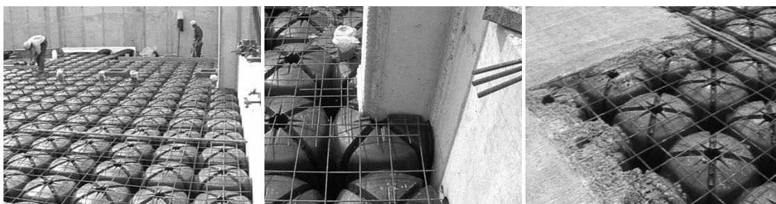
Figure 7 - Phases de montage du plancher Cupolex.
