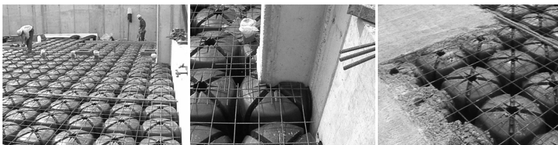
Figura 7 - Fases de montaje del pavimento Cupolex.
