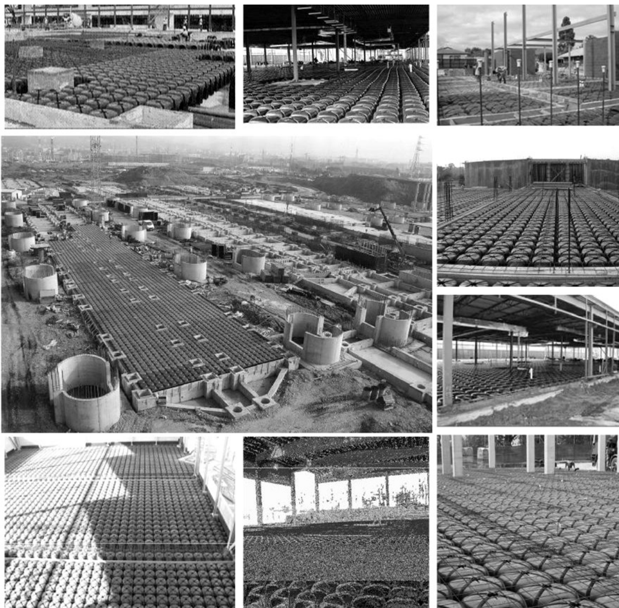
Figura 6 - Ejemplos de instalaciones diversas de pavimentos Cupolex.
