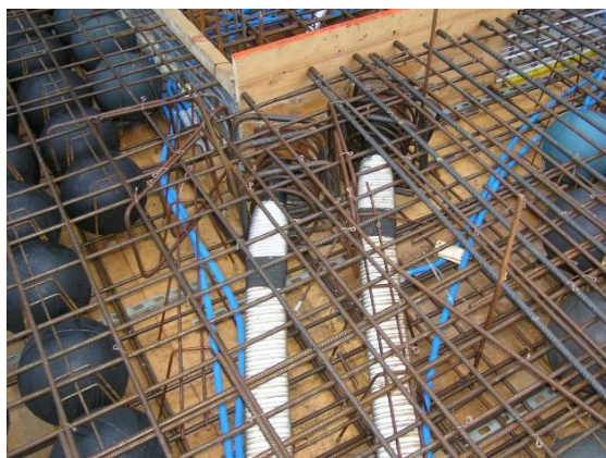
Ejemplos de diversas instalaciones y sistemas de postesado en un forjado COBIAX CLS
