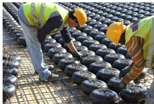
Colocação das grelhas COBIAx CBX diretamente sobre a armadura inferior, fixação com 2/3 nós por grelha
