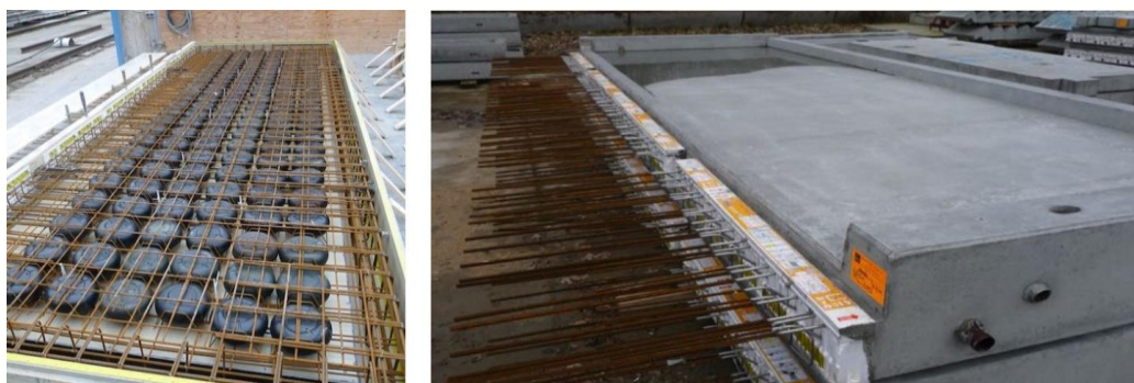
Figure 16 – Dalles COBIAX Préfabriquées
