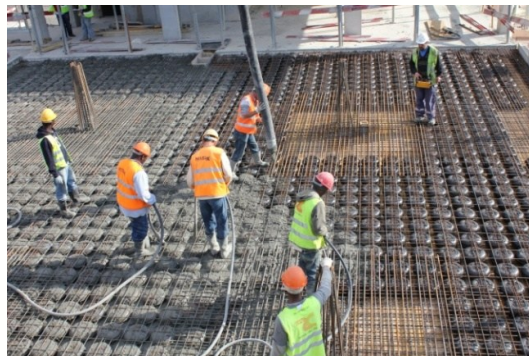
Bétonnage de la 1ère phase, jusqu'à 1/3 de l'épaisseur, ancrant les treillis COBIAX CBX
