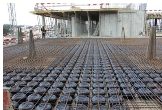
Colocación de la armadura superior sobre las celosías COBIAx CBx
