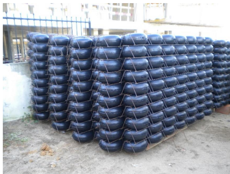
Grelhas assembledas com os moldes, a aguardarem instalação
