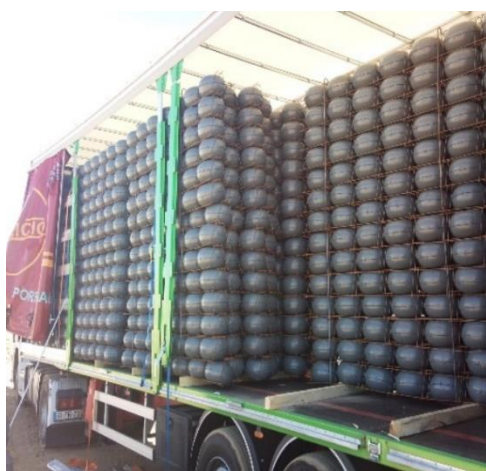
Transporte terrestre de material montado pronto a instalar na laje
