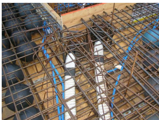
Exemplos de instalações diversas e sistemas de pós-esforço numa laje FERCA CBX
