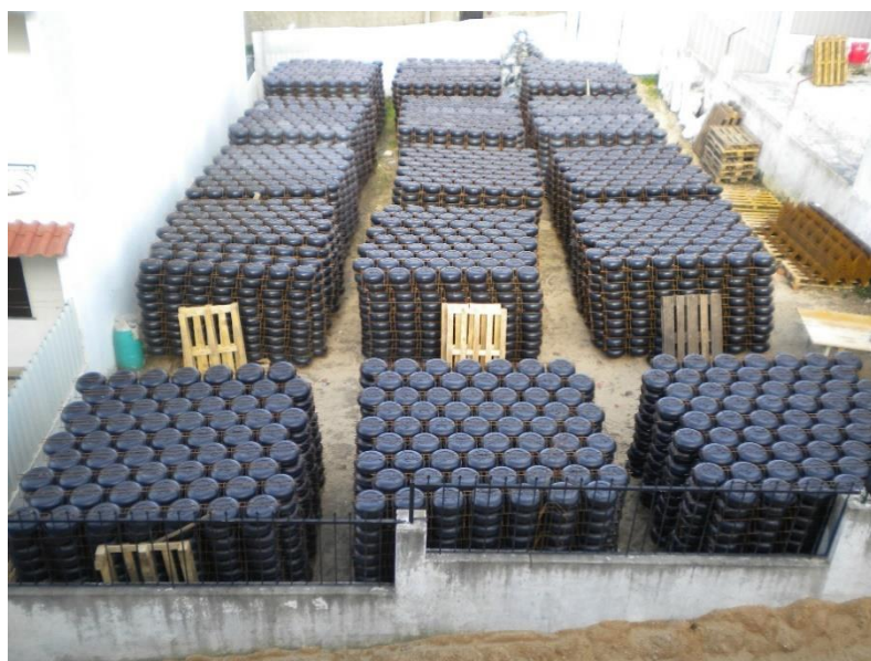
Atados de módulos FERCA CBX prontos para colocar na laje
