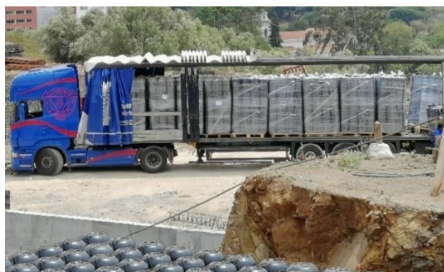
Transporte terrestre de material paletizado pronto para montagem em obra
